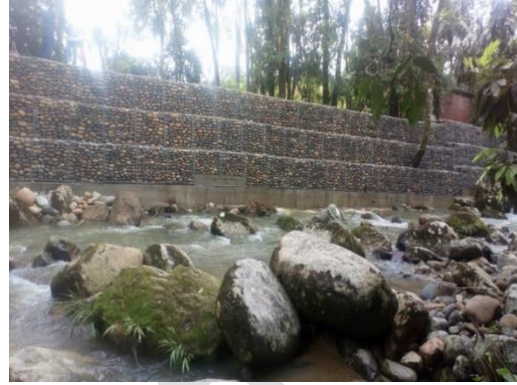
Obra río Acaciñas margen derecha
