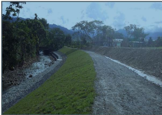
Obra río Acaciñas Nuevo Horizonte
