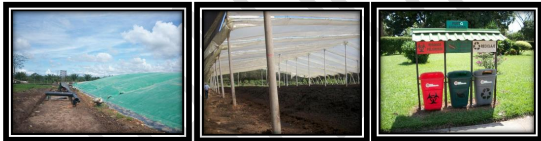
STAR impermeabilización y Biodigestor manejo lixiviados
