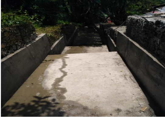
Obra caño San Francisco
