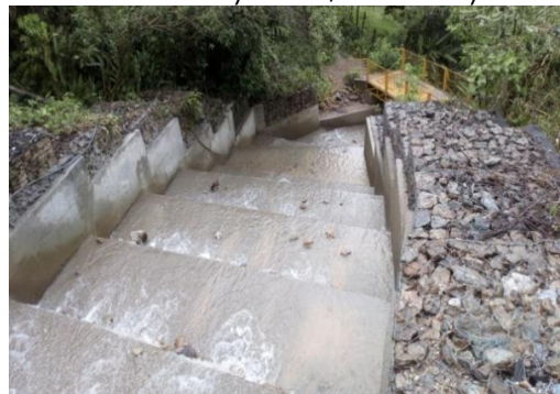
Obra San José, Calvario
